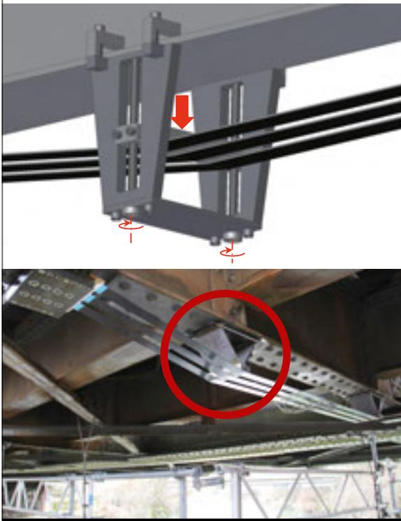
erwarten, so kann das trapezförmige System nachgespannt werden, indem höhere Säulenplatten verwendet werden. Zudem liesse es sich auch problemlos wieder demontieren. Dass die Verstärkung an den zwei Trägern der Münchensteinbrücke leistungsfähig ist, hat ein drahtloses Sensornetzwerk über Monate hinweg aufgezeichnet und nachgewiesen.
