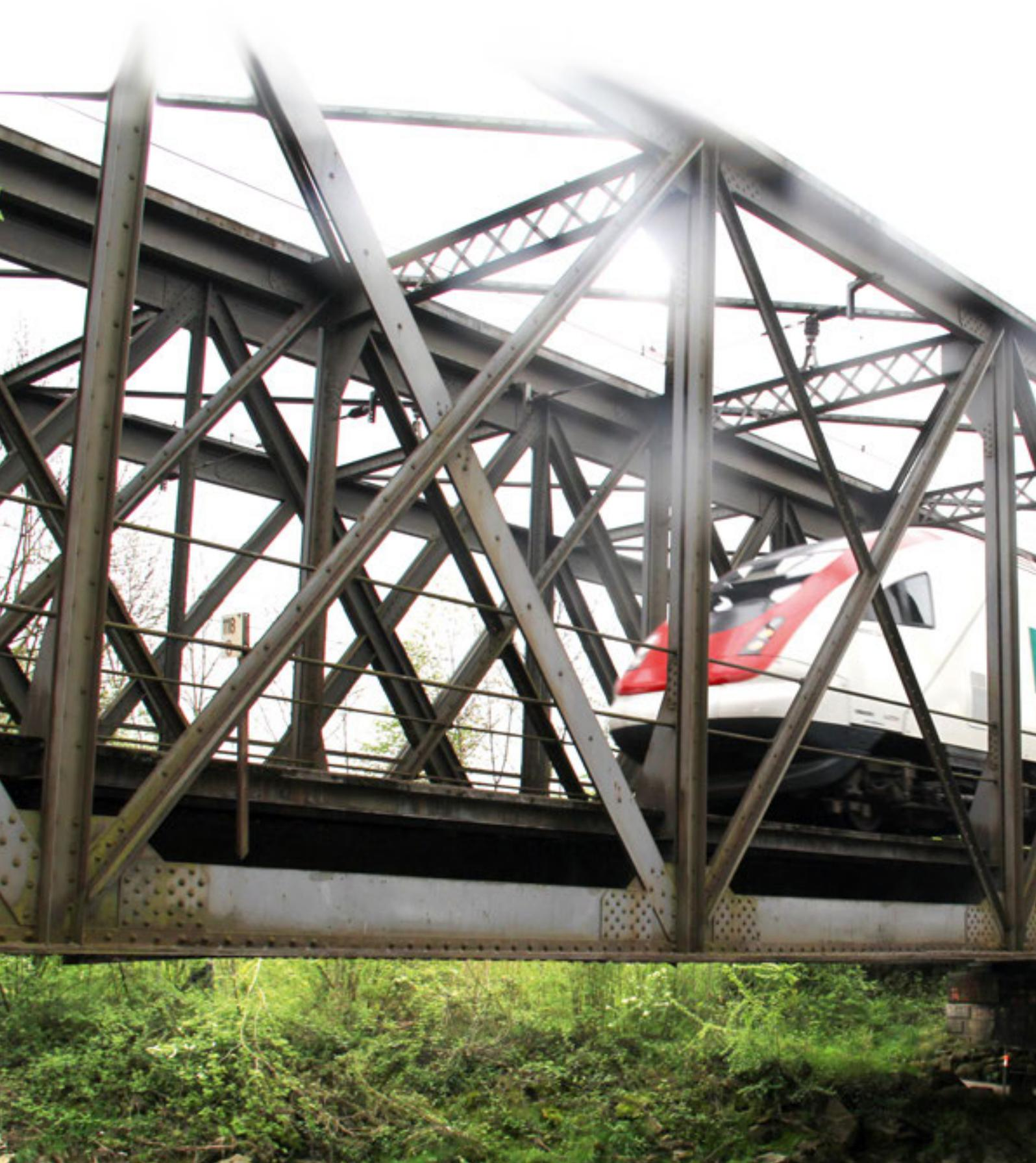
Immer mehr Stahlbrücken müssen wegen Ermüdungserscheinungen ersetzt oder repariert werden. Forscher der Empa verstärken die tragenden Elemente mit vorgespannten, faserverstärkten Kunststofflamellen und fanden damit eine günstige Alternative zum Brückenneubau. Die patentierte Methode wurde an der 120 Jahre alten Münchensteinbrücke eingesetzt.
