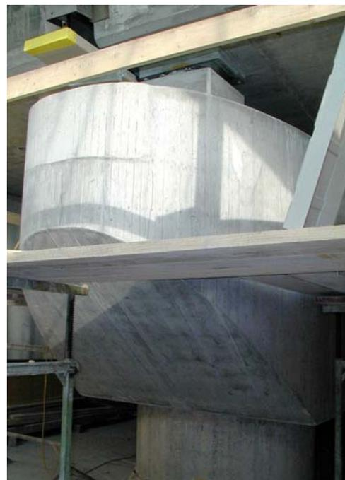
Ein Brückenhammerkopf, der mit SCC reprofiliert wurde.
