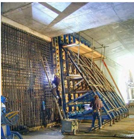
Schalungsarbeiten an einer stark bewehrten Wand, die ideal für die Verwendung von SCC geeignet ist.
