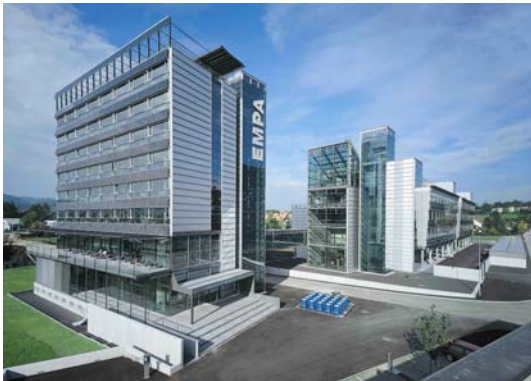
Die Empa-Gebäude an der Lerchenfeldstrasse 5 in St. Gallen
