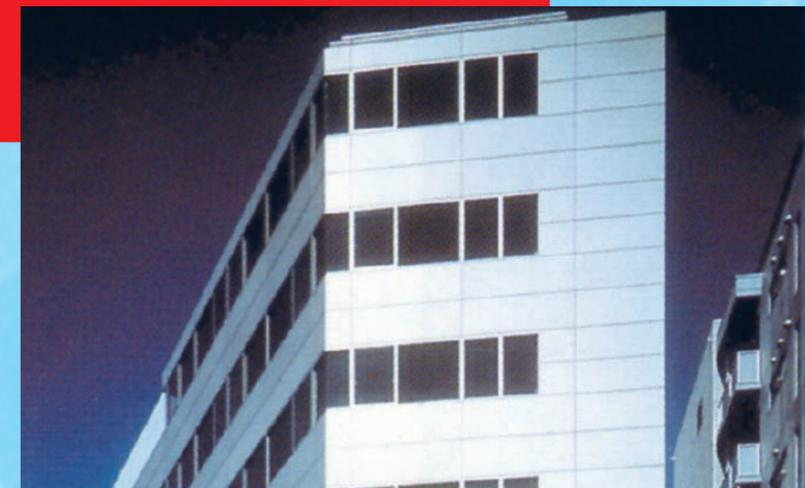
Die Beschichtung der Aluminiumfassade mit Titandioxid macht das Gebäude der YKK Corporation (Japan) praktisch selbstreinigend.
