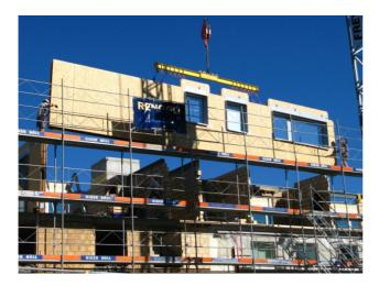
Montage d'un élément de façade préfabriqué comportant déjà les fenêtres, les conduites, les canaux de ventilation et l'isolation thermique sur un bâtiment ancien pour sa surélévation.
