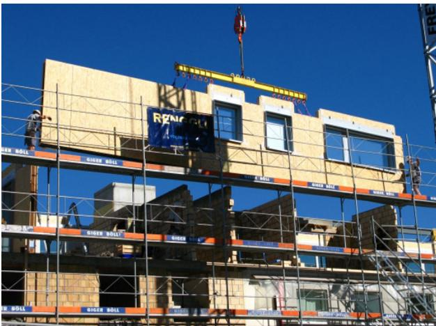
Montage eines vorgefertigten Fassadenelements inkl. Fenster, Leitungen für Medien und thermische Isolation auf einen aufgestockten Altbau.
