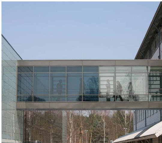
Vitrage commutable au Fraunhofer Institut IST à Braunschweig en Allemagne. La moitié gauche du vitrage de la passerelle est obscurcie. Source: EControl Glas, Plauen, Allemagne.
