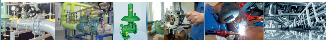
GASDRUCKREDUZIER- U. MESSANLAGEN
