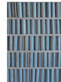
De vieilles moquettes comme matériau d'isolation acoustique pour les cloisons de bureaux ? Ça marche ! Et ça a l'air bien. L'unité NEST Sprint établit de nouvelles normes en matière de bâtiments recyclés et a été construite en dix mois seulement (page 19).
