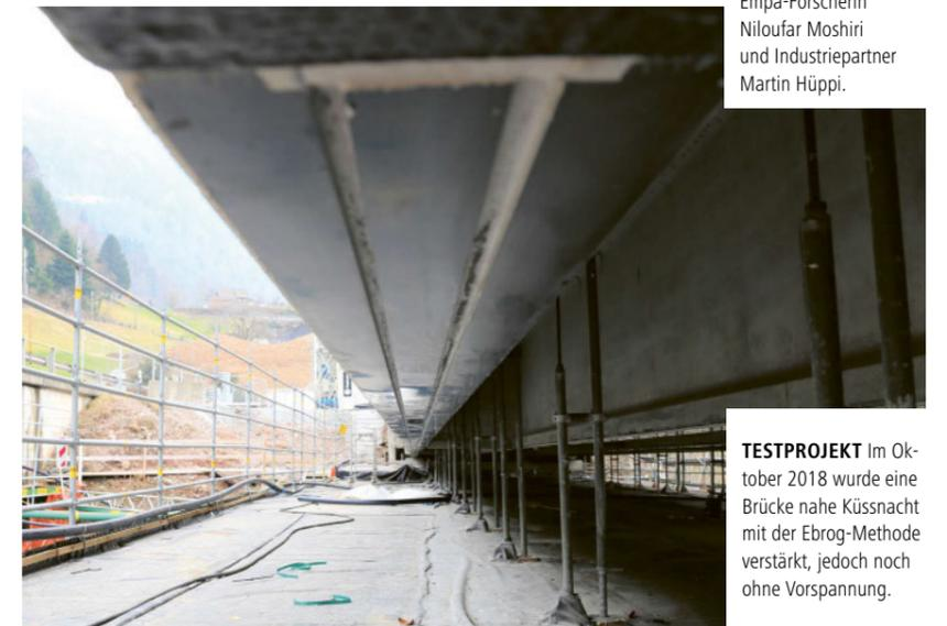
**TESTPROJEKT** Im Oktober 2018 wurde eine Brücke nahe Küssnacht mit der Ebrog-Methode verstärkt, jedoch noch ohne Vorspannung.
