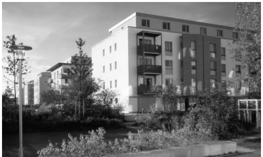
Gebäude an der «Friedenspromenade» mit unterschiedlichen Aussenwandkonstruktionen.
