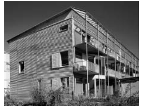
Holzrahmenbau in Niedrigenergiebauweise.
