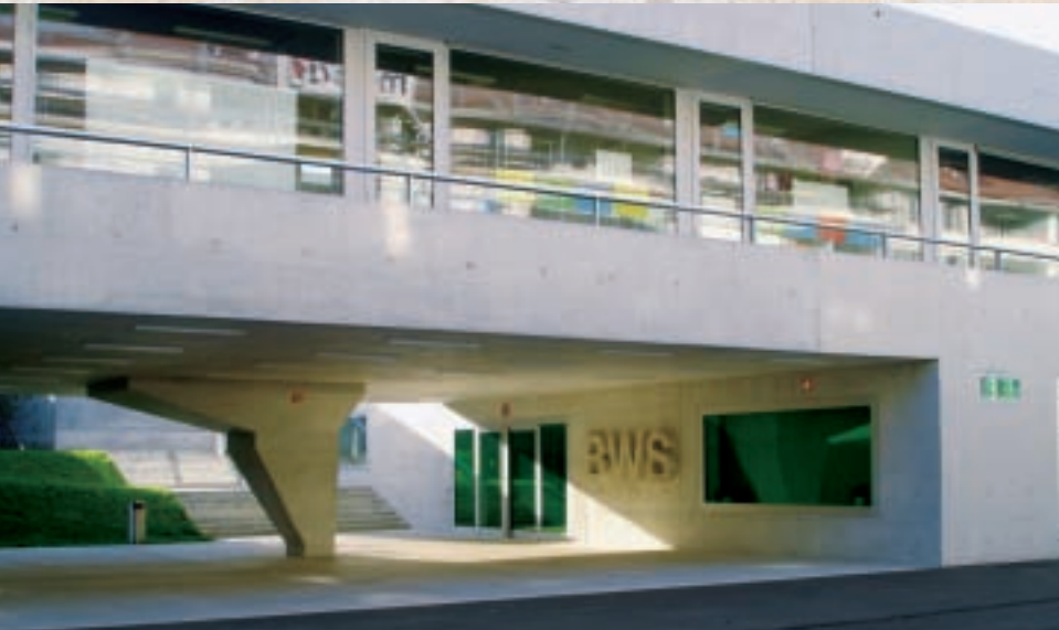
Gebäude mit RC-Beton
