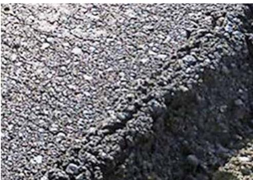
Bild 4: Kantenabbrüche aufgrund mangelnder Schulterstabilität
