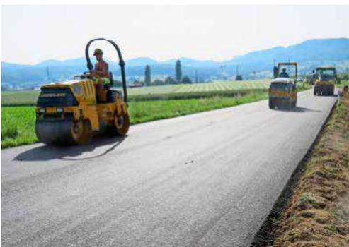
Bild 5: Fertig eingebaute Schicht aus Recyclingmaterial
