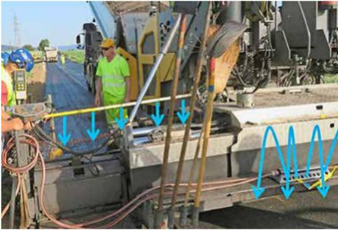
Bild 2: Wasserzufuhr in die Fertigerschnecke und hinter der Einbaubohle
