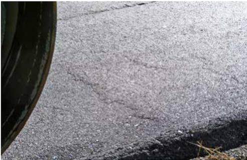
Bild 3: Durch Walze hervorgerufene Querrisse
