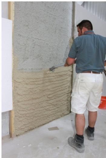
Der Aerogel-Hochleistungsdämmputz wird mit der Verputzmaschine aufgespritzt und nachher glatt gezogen. Der weiche Dämmputz muss in einem weiteren Arbeitsgang mit einem gewebearmierten Einbettmörtel versehen werden (Bild: Fixit AG).
