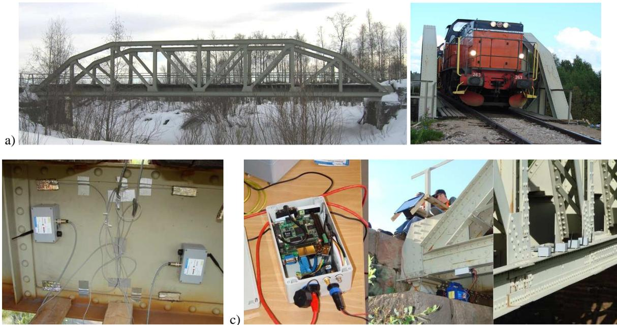
Abb. 6: a) Eisenbahnbrücke. b) Auf einem Stahlträger montierte Dehnmessstreifen mit Sensorknoten. c) Basisstation (links); Energieversorgung der Basisstation mit Autobatterien und Photovoltaik-Panel (Mitte); Sensorknoten auf dem Längsträger.
