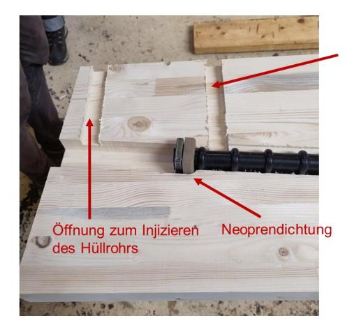
Öffnung zum Injizieren des Hohlraums Hüllrohr und Holz
