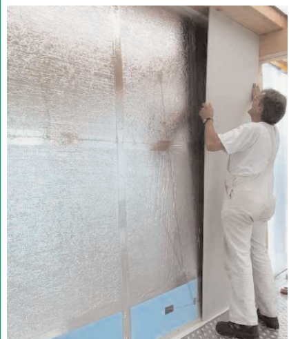
Verlegung von 2 cm dicken Vakuum-Panelen als Innenisolation
