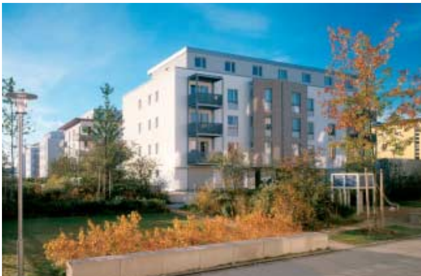
Die fünf Gebäude an der Felicitas-Füss-Straße mit unterschiedlichen Außenwandkonstruktionen; Bauträger GEWOFAG
