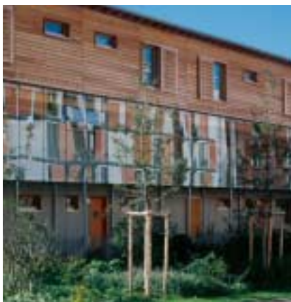
Nordfassade des Gebäudes Georg-Kerschensteiner-Straße 12.
