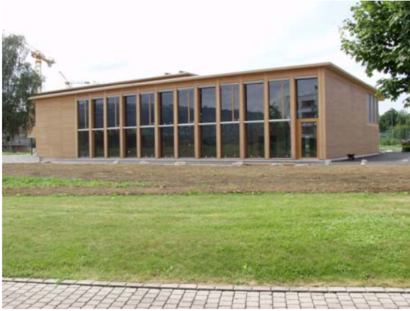
Bild 2.3 Sporthalle des Schulhauses Riedmatt bei Zug (links) und Innenansicht mit Öffnung für die Platzierung der Messfühler (rechts). Ausführung der Messungen durch die EMPA.
