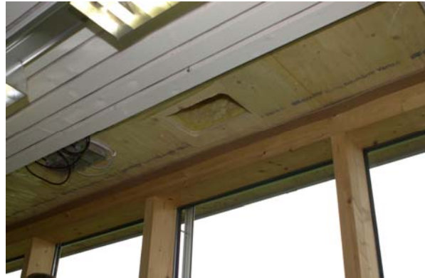
Bild 2.1 Schulhaus Romanshorn (links) und Innenansicht mit Öffnung für die Platzierung der Messfühler (rechts). Ausführung der Messungen durch die EMPA.
