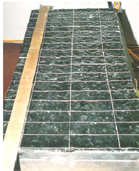
Bild 11 Einschnürung der Muldenbreite bei Fugenöffnung
