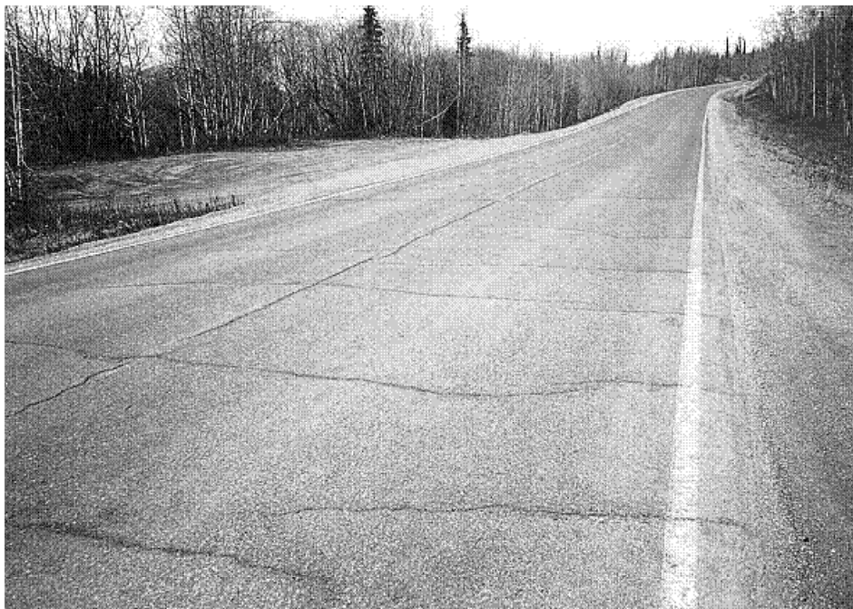
Abbildung 1 Abkühlrisse in Regionen mit raschen extremen Temperaturstürzen
