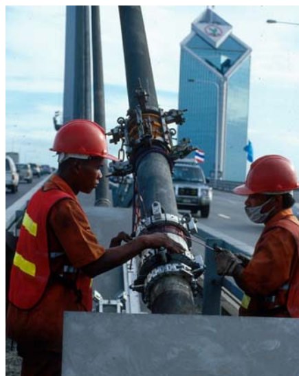
Contrôle des câbles du pont Rama IX à Bangkok avec la méthode développée par l'Empa
